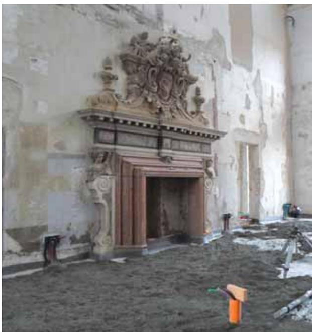
Sottofondo leggero ad elevata compattezza superficiale e rapido indurimento costituito da Sottofondo CentroStorico, premiscelato a base di argilla espansa Lecapiù (assorbimento di umidità circa 1% a 30'), cemento tipo Portland e additivi. Densità in opera circa 650 Kg/m<sup>3</sup>, resistenza media a compressione certificata 7,0 N/mm<sup>2</sup> (a 28 gg).
