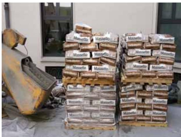
Massetto leggero fibrorinforzato per bassi spessori e a rapida asciugatura costituito da Massetto CentroStorico, premiscelato a base di argilla espansa Lecapiù (assorbimento di umidità circa 1% a 30'), inerti naturali, fibre polimeriche, cemento tipo Portland e additivi adatto a ricevere la posa di pavimenti incollati (anche sensibili all'umidità). Densità in opera circa 1250 Kg/m<sup>3</sup>. Resistenza a compressione certificata 18 N/mm<sup>2</sup> (a 28 gg).
