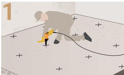
Segnare le distanze a cui vanno posizionati i connettori. Eseguire il preforo con un trapano e una punta da 8 mm.
